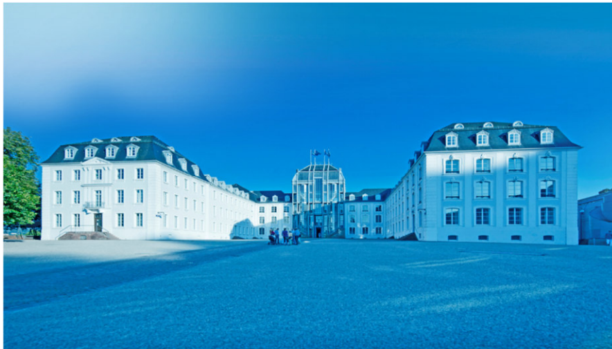
Saarbrücker Schloss: Dienstgebäude der Geschäftsstelle des Gutachterausschusses
